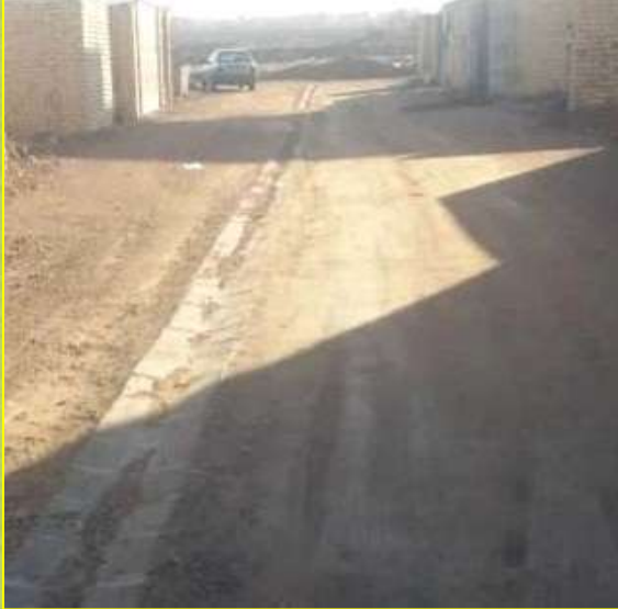
اجرای کانپو و زیرسازی کوچه ۲۲ خیابان جمهوری
