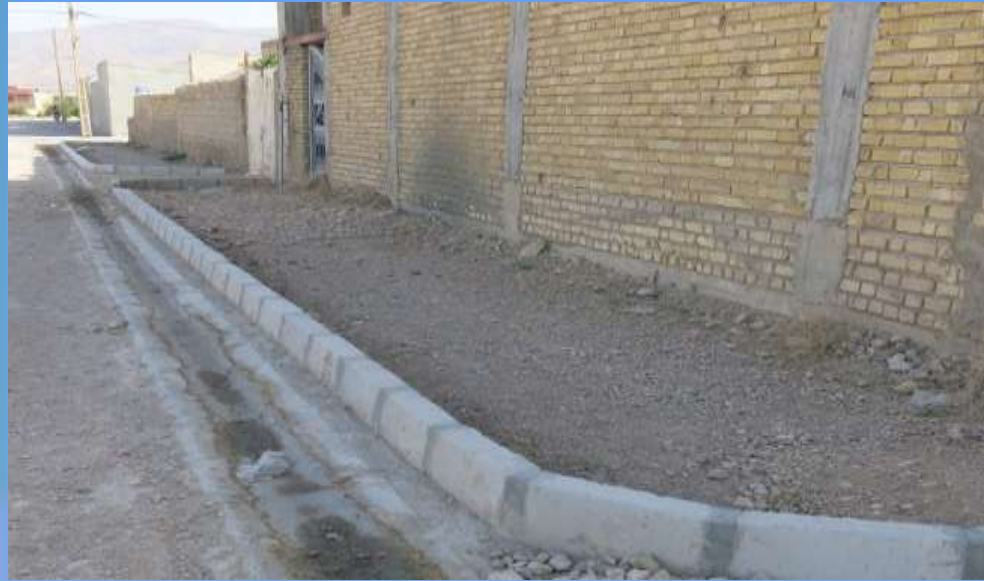
اجرای تک لبه خیابان پیروزی
